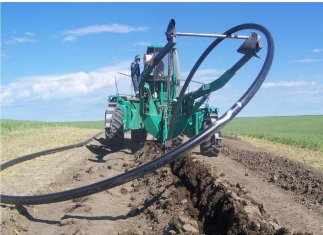
**FIGURE 3 - PIPELINE PLOW**
