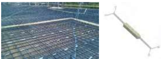
Figuras 4, 5 e 6: Anodos de proteção catódica instalados durante a armação das ferragens e antes da concretagem.
