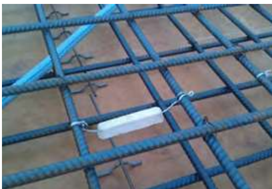
Figuras 8, 9 e 10 e 11: Anodos de proteção catódica sendo instalados durante os serviços de recuperação estrutural.
