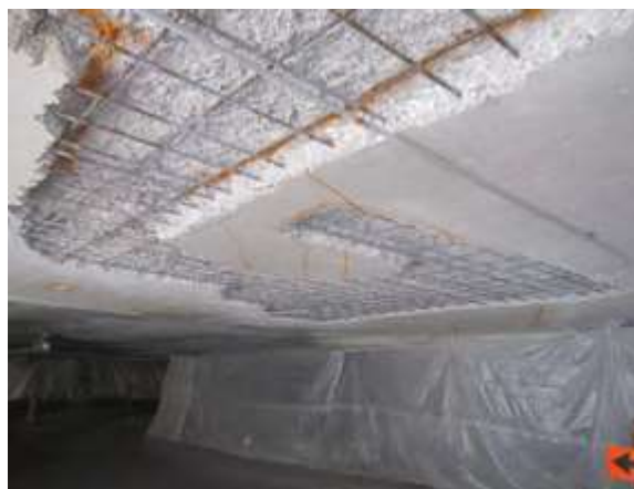
Figuras 1 e 2: Fotos de ferragens corroídas, situações comuns de serem observadas em pontes, viadutos e edificações.
