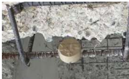
Figuras 8, 9 e 10 e 11: Anodos de proteção catódica sendo instalados durante os serviços de recuperação estrutural.
