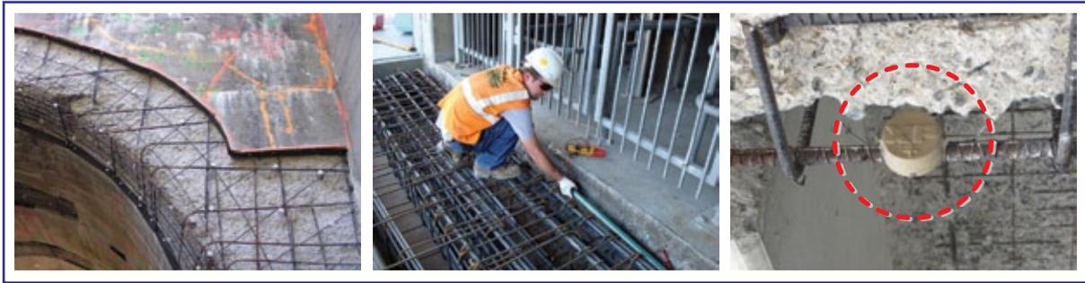
Exemplos de instalação dos anodos galvânicos em estruturas em operação (sem a necessidade das ferragens estarem aparentes)
