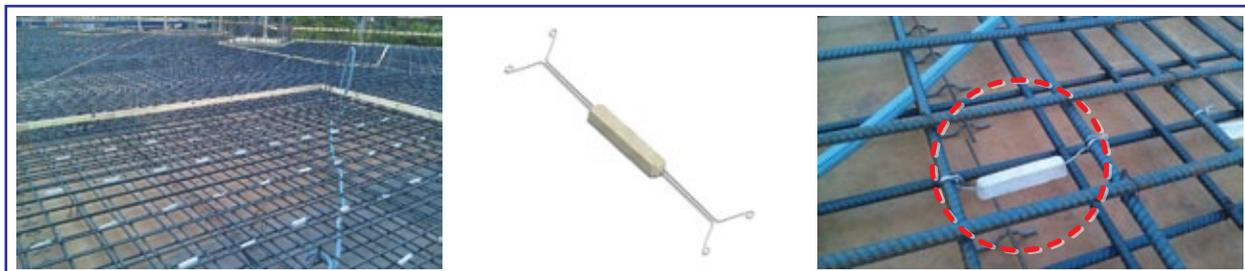
Exemplos de instalação dos anodos galvânicos durante as atividades de recuperação estrutural (com as ferragens aparentes)
